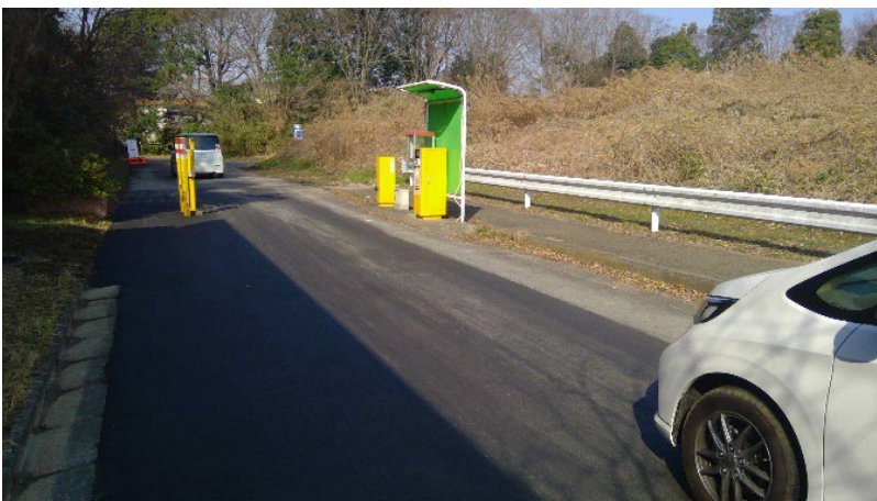
図2 路面補修後の状態
