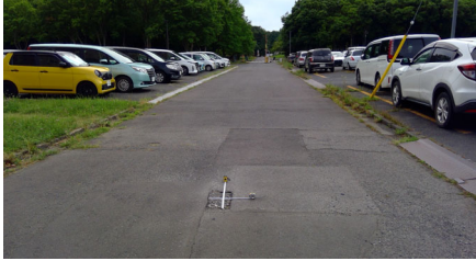
1・ K25・第三エリアゲート内通路
